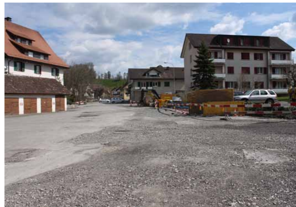
Der Ausbau der Dorfstrasse, dessen Baubeginn am 2. Februar 2015 erfolgte, ist in vollem Gange. Die Bauarbeiten werden im Sommer 2017 mit dem Einbau des Deckbelages abgeschlossen sein.
