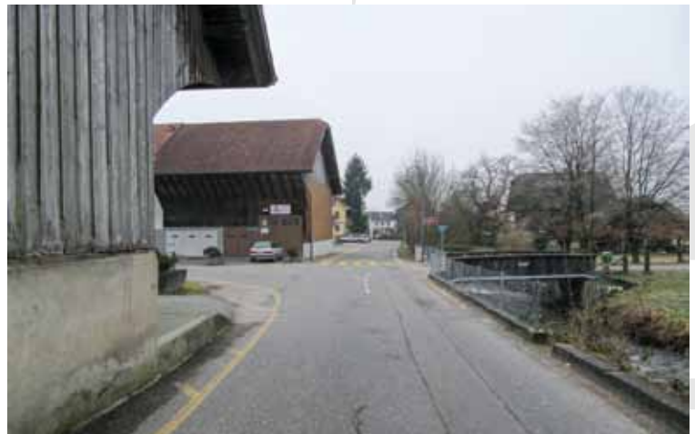
Die beiden unmittelbar am Strassenrand stehenden Scheunenkörper grenzen den Strassenraum zusammen mit dem Bach stark ein. Der aufgemalte Gehwegbereich ist zu schmal und schlecht gesichert.
