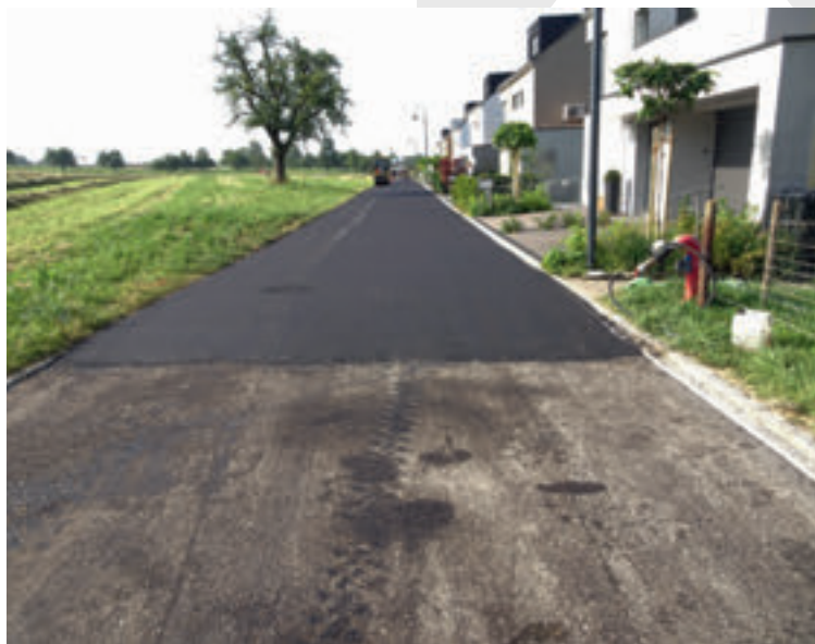
Ruetigstrasse: Der noch fehlende Deckbelag auf einer Länge von rund 30 m
