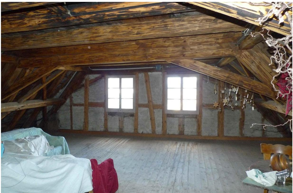
Dachkonstruktion im Kernbau mit liegendem Stuhl (2016)
