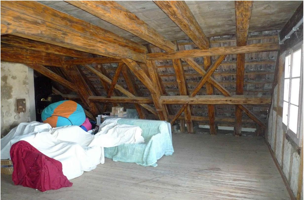
Dachkonstruktion mit Andriaskreuzen, um 1750 (2016)
