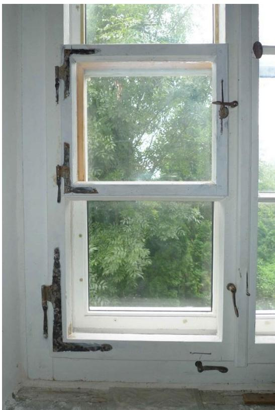
Lüftungsfenster und originale Beschläge, Fenster im 3. OG (2016)
