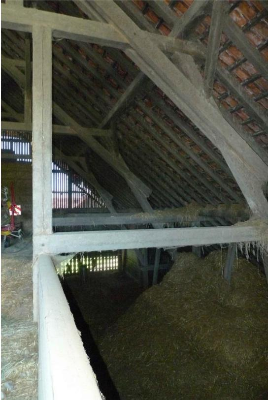
Dachkonstruktion, zangenartige Aussteifung (2016)
