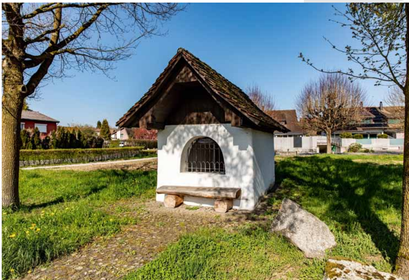
Die St. Nikolaus-Kapelle auf der Chäppeliwiese steht unter kantonalem Denkmalschutz.
